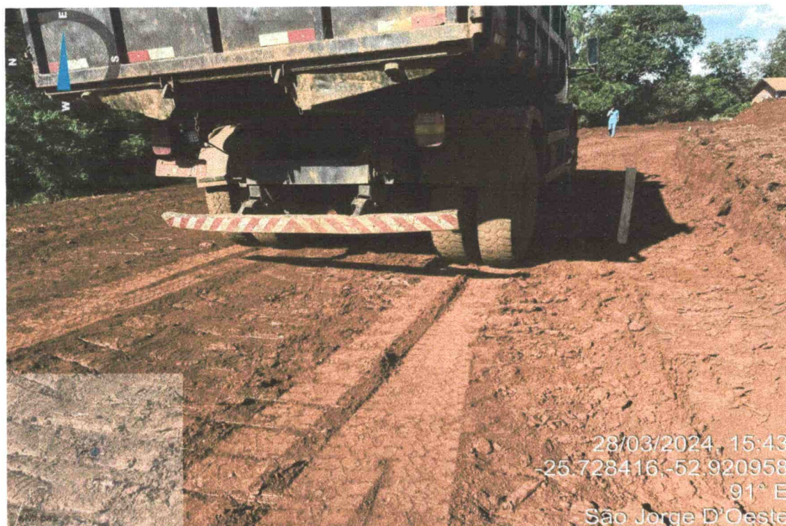
Foto 35: estaca 02 Rua dos Lirios, bordo direito – sem deformação
