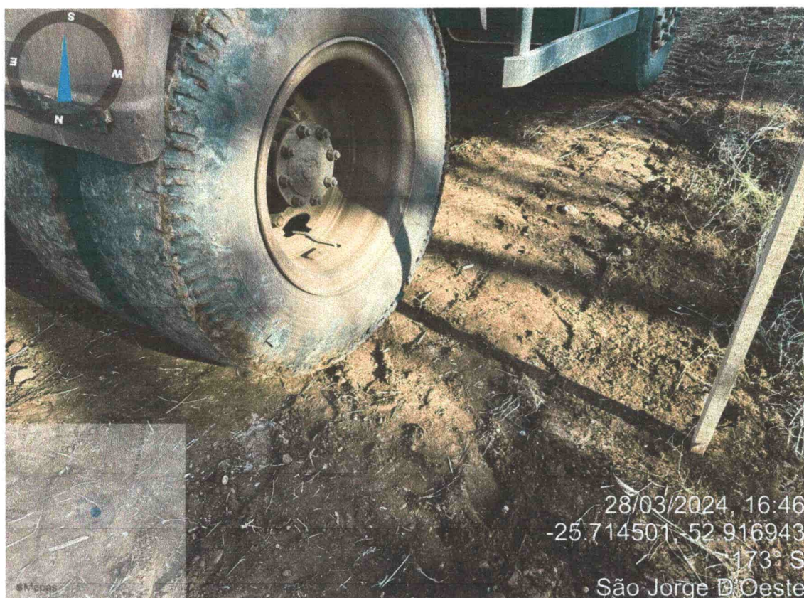
Foto 17: estaca 05 Trecho 03 na Avenida Santa Catarina, bordo direito – sem deformação
