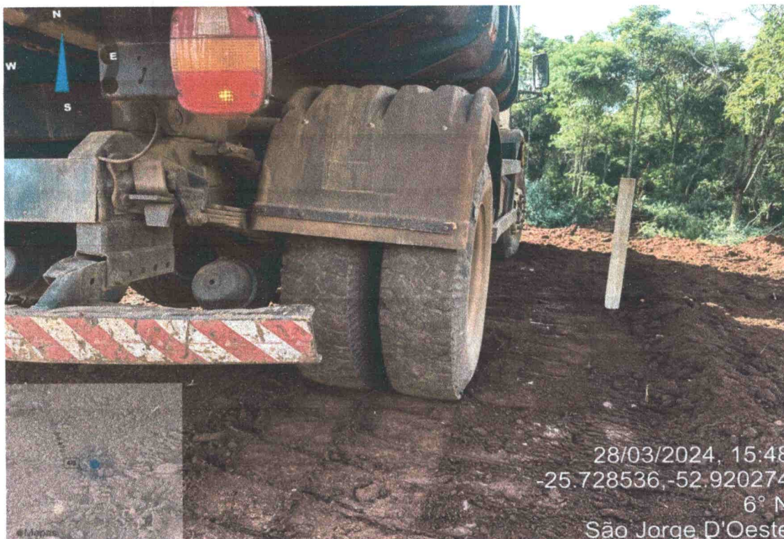
Foto 38: estaca 04 Rua das Dalias, bordo direito – sem deformação
