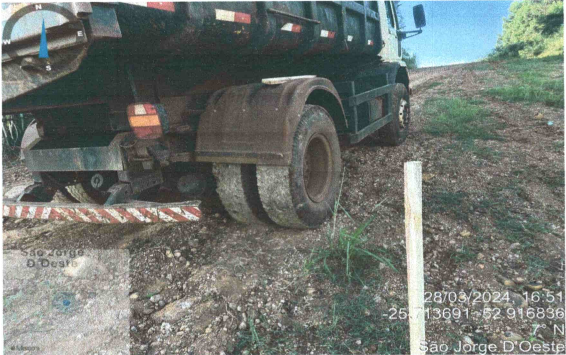
Foto 10: estaca 01 Trecho 02 na Avenida Santa Catarina, bordo direito – sem deformação
