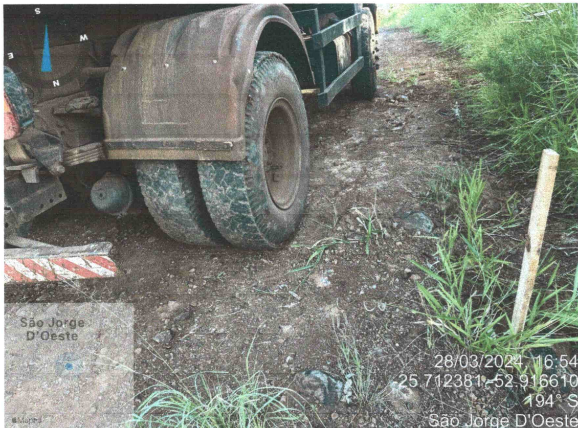
Foto 11: estaca 03 Trecho 02 na Avenida Santa Catarina, bordo direito – sem deformação
