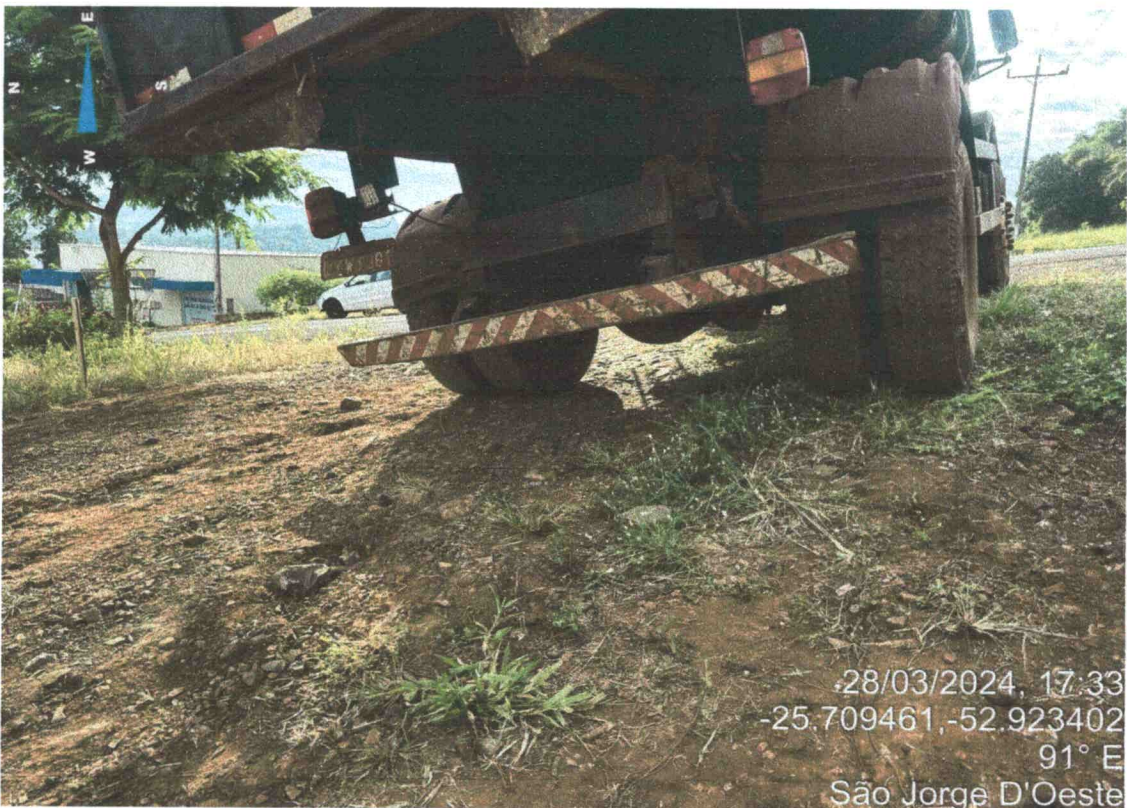
Foto 47: estaca 01 Avenida Arnaldo Bussato, bordo esquerdo – sem deformação
