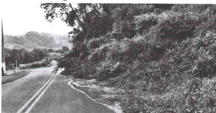
Meia pista da estrada que dá acesso à comunidade de São Luiz e a fábrica de Papel da Penha ficou interditada por quase todo o domingo por causa do desabamento da encosta.
