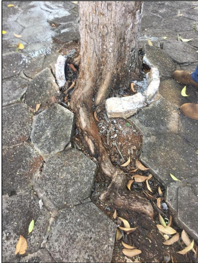
Figura 14 – Árvores com Raízes Superficiais danificando calçadas.
