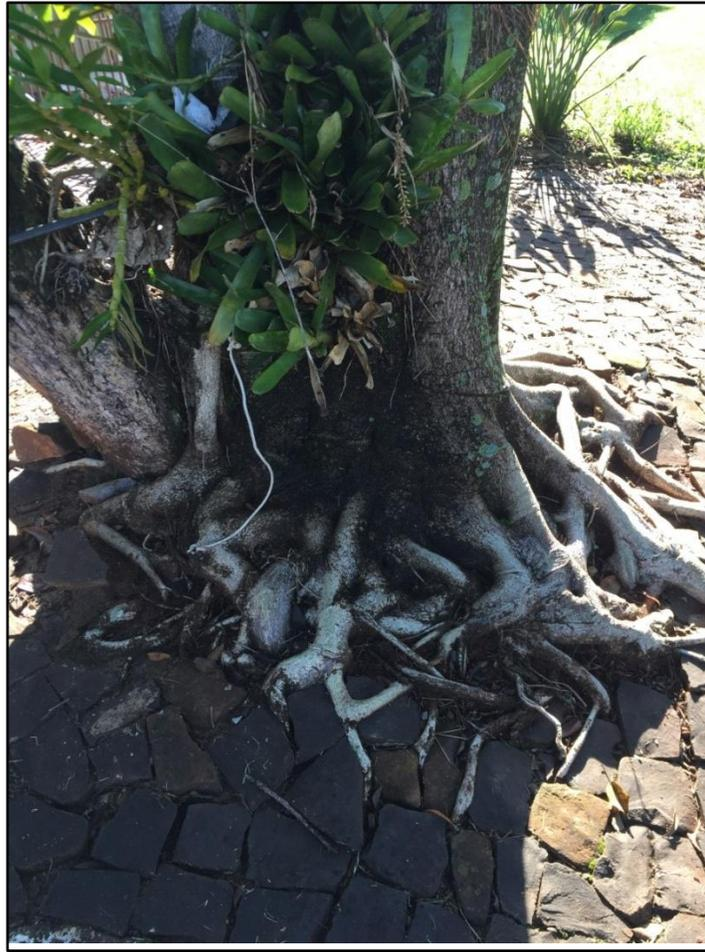
Figura 15 – Árvores com Raízes Superficiais danificando calçadas.
