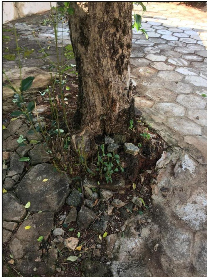
Figura 13 – Árvores com Raízes Superficiais danificando calçadas.
