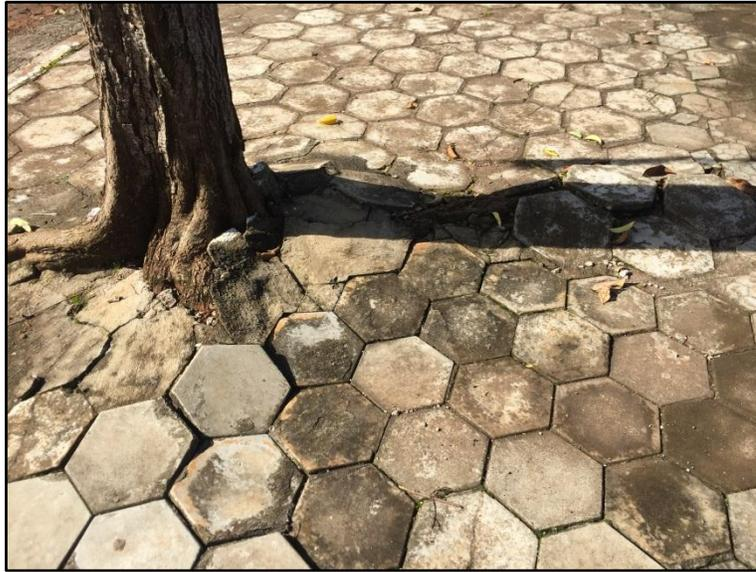
Figura 12 – Árvores com raízes superficiais danificando calçadas.
