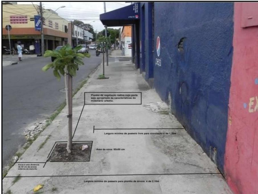
Figura 39 – Exemplo de calçadas, deixando 1,20 m livre para o passeio.
